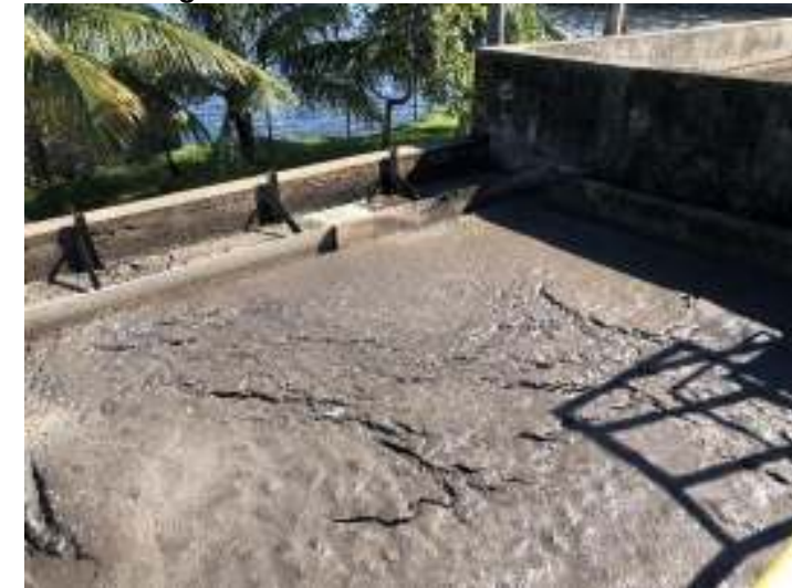
Figura 206: Armazenamento de Lodo.
