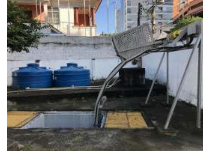
Figura 138: Gradeamento Automatizado
