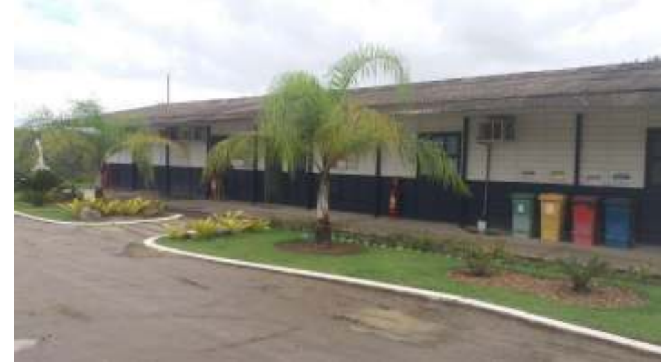
Figura 317: Prédio administrativo – unidades de apoio.
