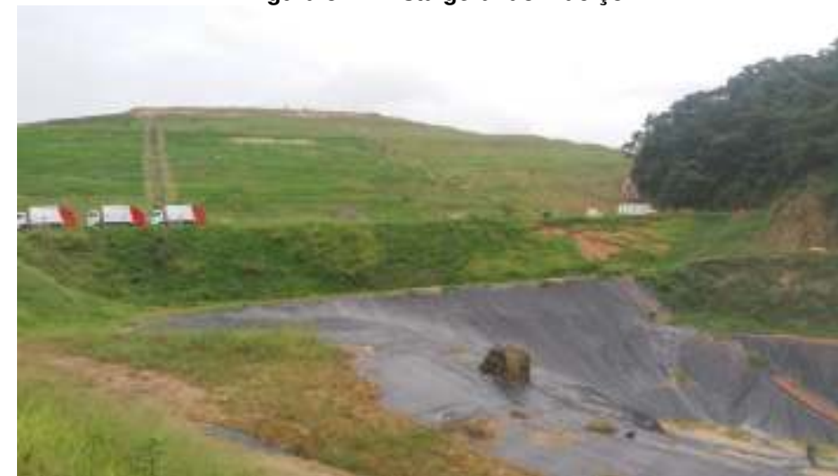
Figura 311: Vista geral do maciço.
