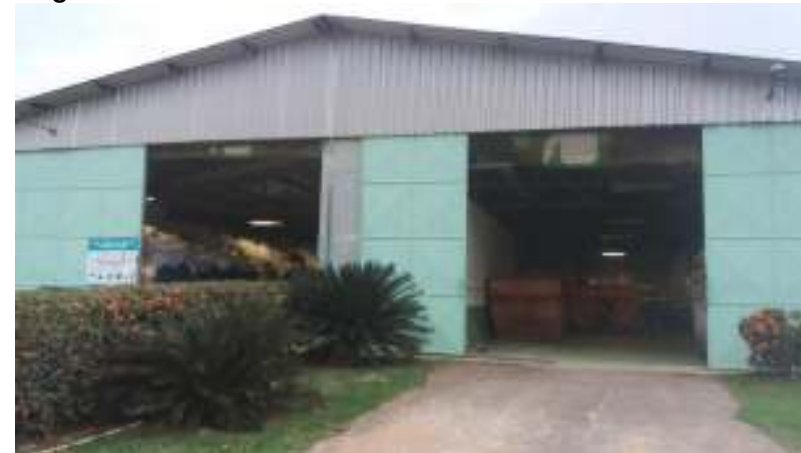
Figura 334: Vista externa da Unidade de Tratamento dos RSS.
