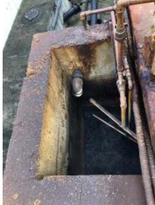
Figura 171: Aplicação de Cloreto Férrico.
