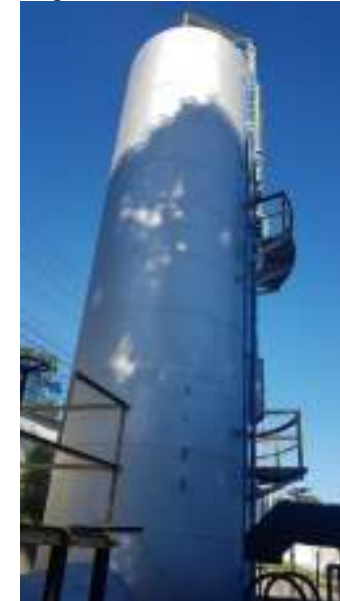
Figura 65: Torre de Alívio.
