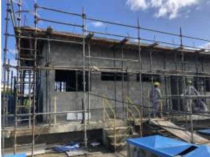
Figura 164: Obras de Ampliação da ETE Camboinhas.
