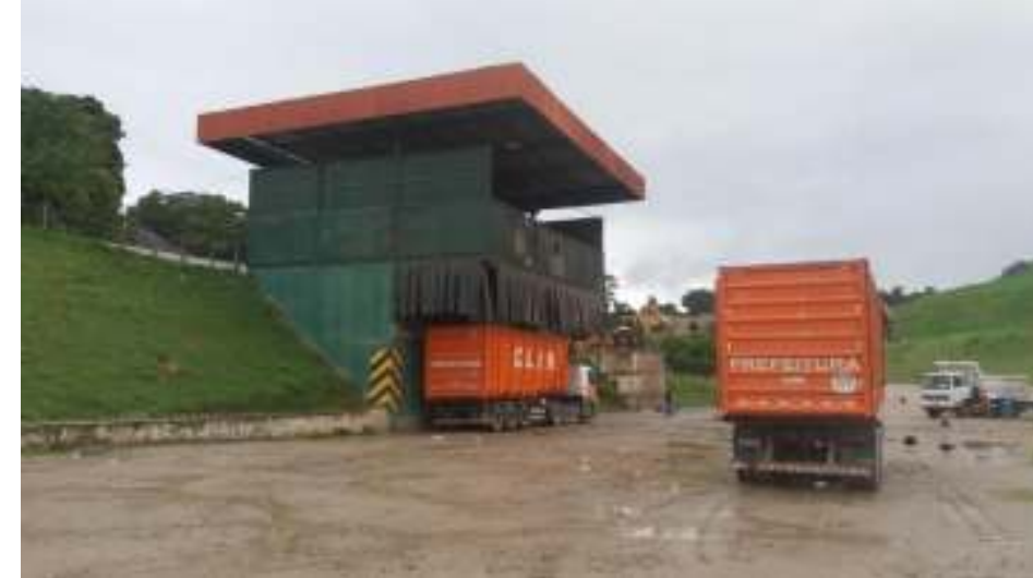
Figura 307: Vista Geral da Estação de Transbordo.
