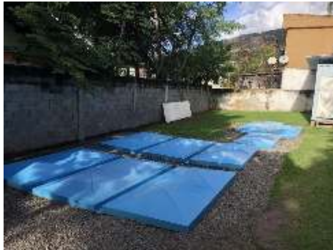
Figura 189: Tratamento Preliminar - Gradeamento e Caixa de Areia.
