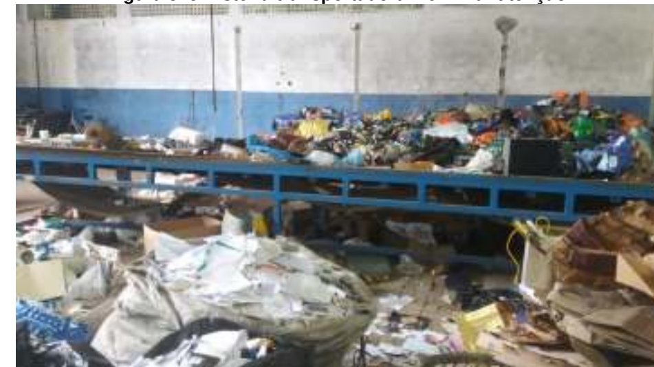
Figura 323: Esteira transportadora – em manutenção.
