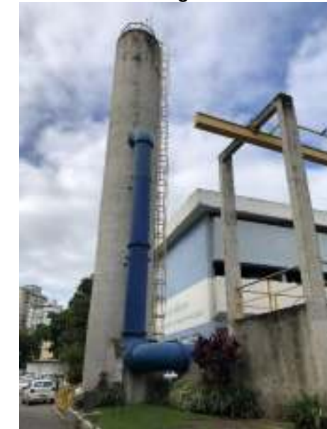
Figura 174: Chaminé de Carga do Emissário Submarino.
