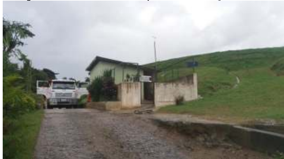
Figura 306: Vista frontal da sala operacional e balança rodoviária.
