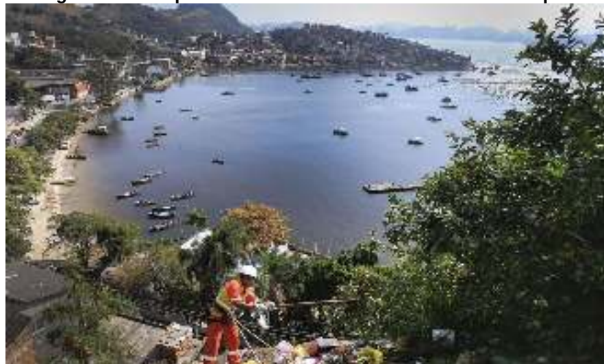
Figura 270: Limpeza de encostas utilizando técnicas de rapel.
