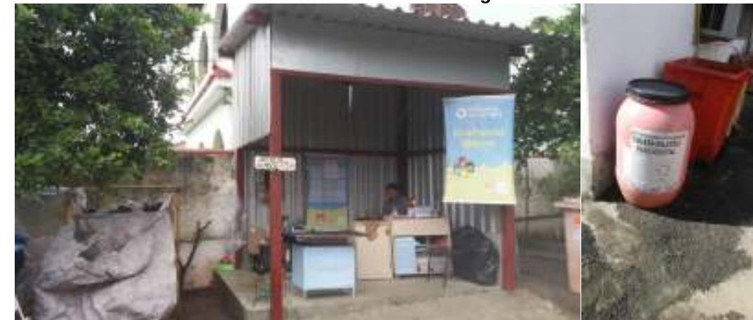
Figura 300: Vista externa do PEV EcoCLIN/Ecoenel localizado 12 DLU Santa Bárbara, destaque para Coleta seletiva de óleo vegetal
