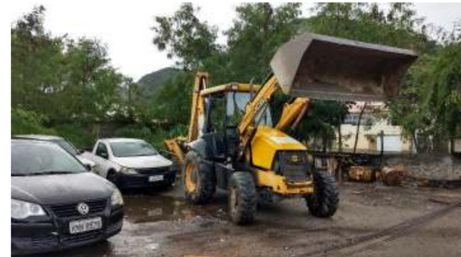
Figura 227: Retroescavadeira para uso nos serviços.
