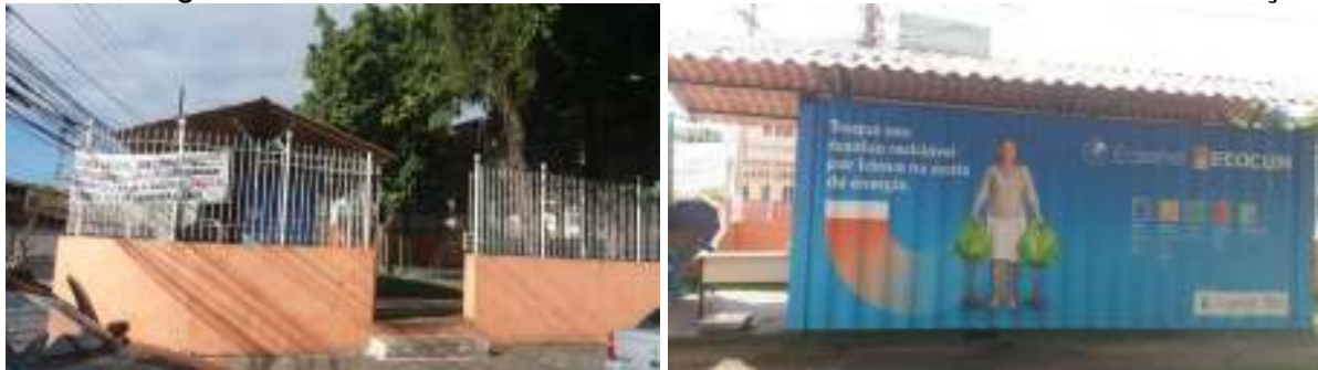
Figura 298: Vista externa do PEV EcoCLIN/Ecoenel localizado na Ilha da Conceição.
