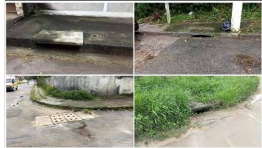
Figura 239: Tipos de Unidades do Sistema de Microdrenagem Urbana em Niterói - continuação.
