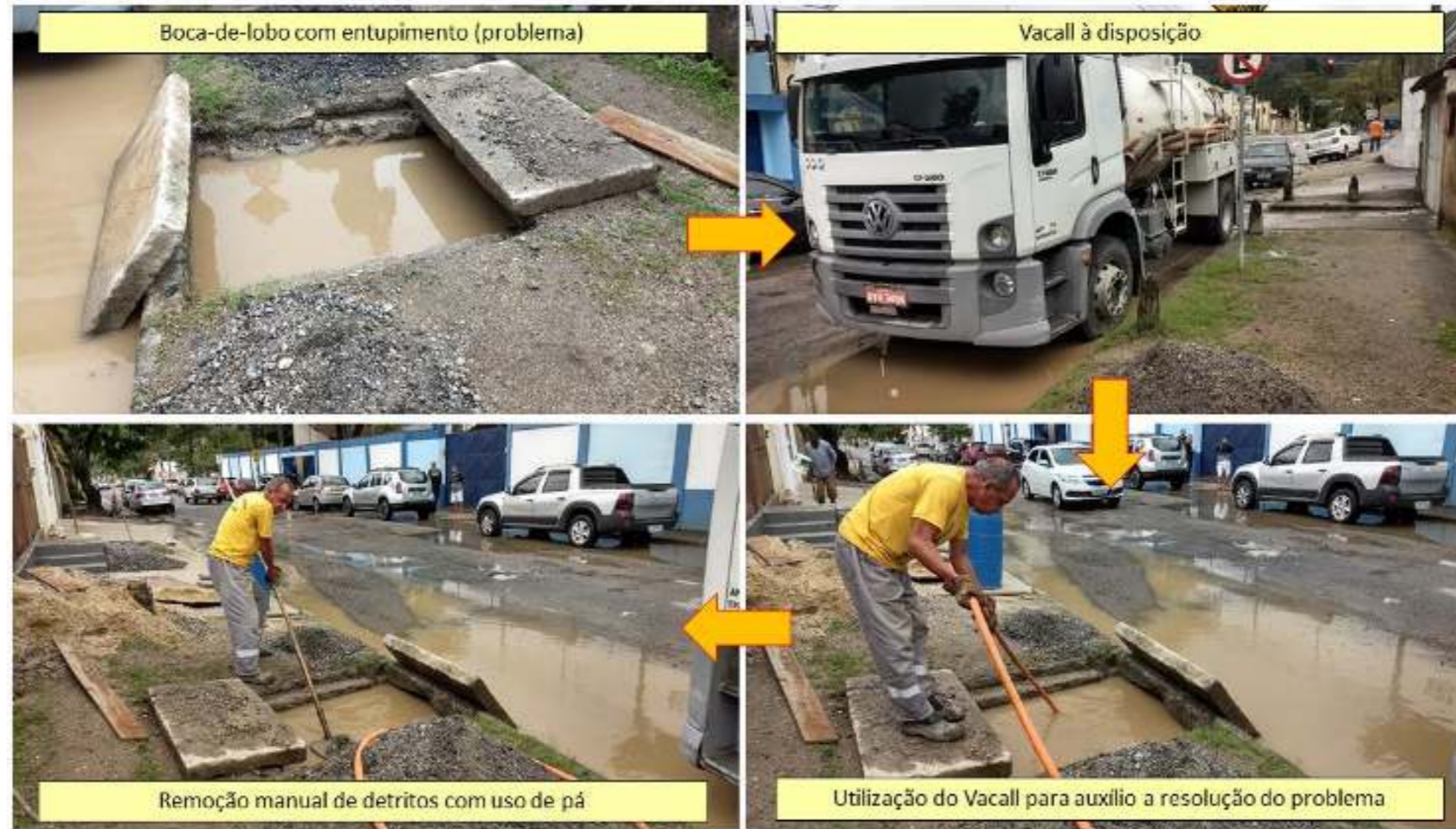
Figura 230: Exemplo de Procedimentos de Limpeza no Sistema de Microdrenagem – uso do Vacall.
