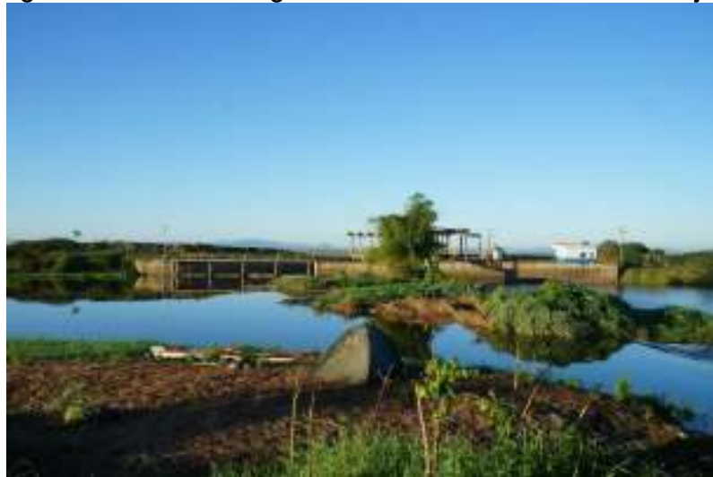
Figura 52: Tomada de Água Bruta do Sistema Imunana-Laranjal.
