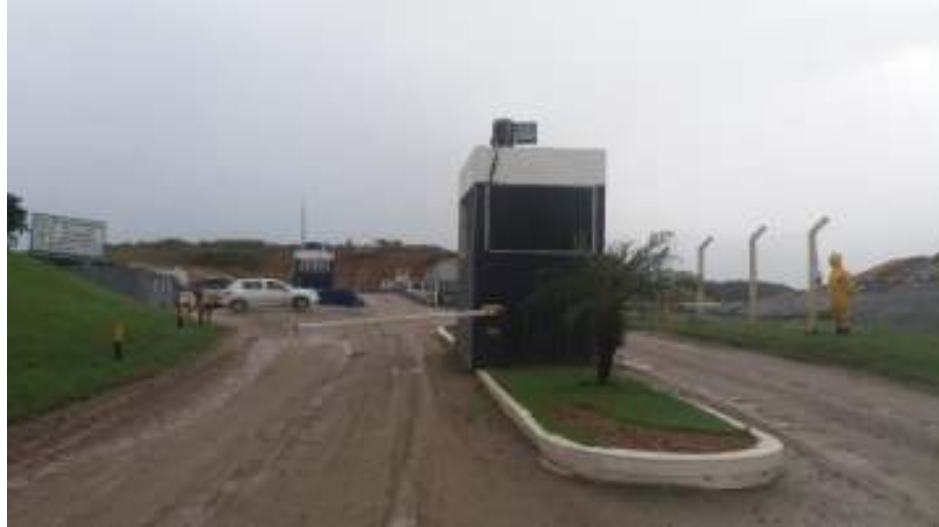
Figura 315: Vista geral da entrada da CTR- São Gonçalo.
