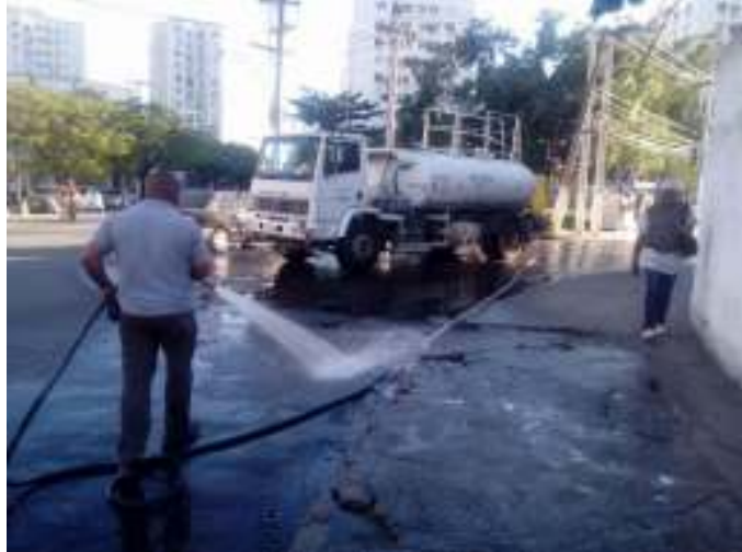
Figura 142: Lavagem de Logradouros com Água de Reuso.
