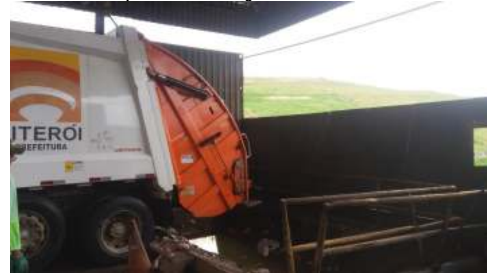
Figura 308: Caminhão compactador descarregando os resíduos no caminhão roll-on roll-off.
