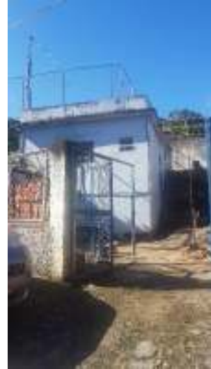
Figura 72: Booster do Reservatório Pires.
