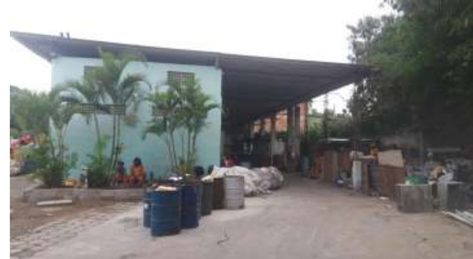
Figura 329: Vista externa galpão de triagem no pátio da CLIN.
