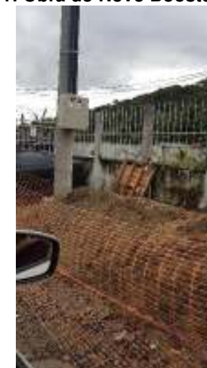
Figura 111: Obra do Novo Booster Pendotiba.
